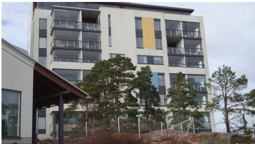
Kuva 7.1.1 Kerrostaloasunnon energiankulutus on pääasiassa kaukolämpöä.
