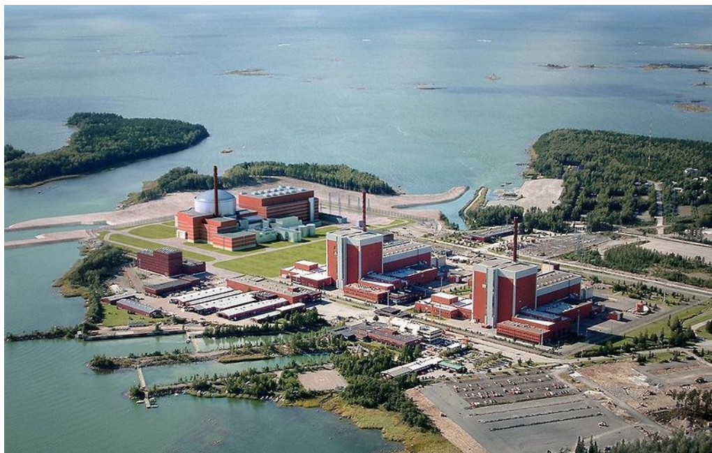
Kuva 2.2.1 Olkiluodon ydinvoimala on maamme suurin voimala. Sen 1. ja 2. yksiköiden sähkötehot ovat 860 MW ja 3. yksikön teho on 1600 MW (vasemmalla).
