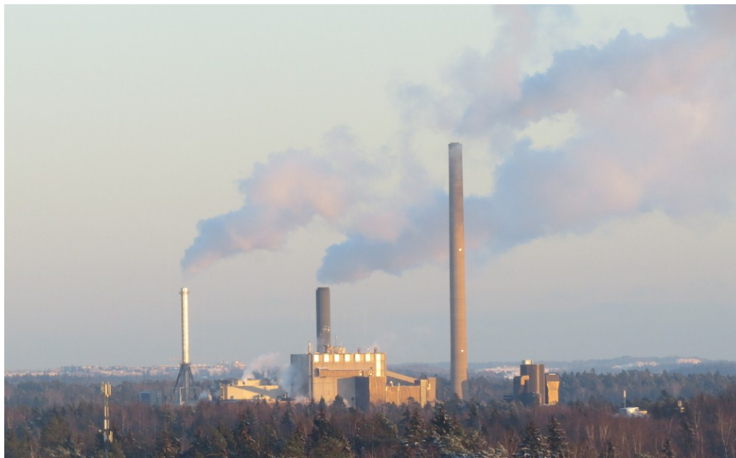
Kuva 2.3.3 Suomenojan voimalaitoksella ovat kaikki yksiköt käytössä kovilla pakkasilla. Vasemmalla kaasurpiinin, keskellä kombivoimalan ja oikealla hiilivoimalan piiput.
