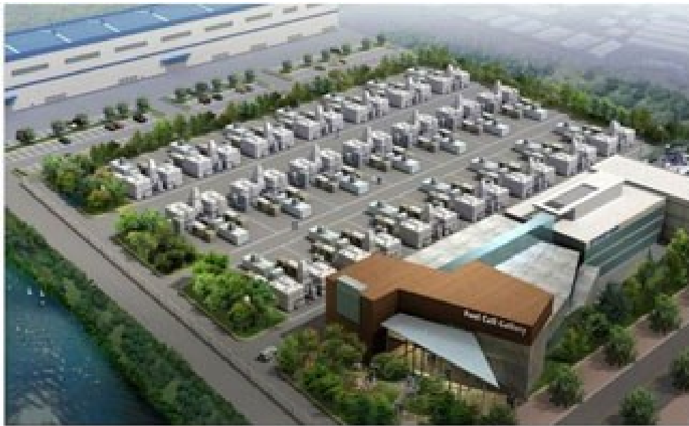
Kuva 2.1.11 Maailman suurin polttokennovoimala on rakenteilla Soulissa. Sen on teholtaan 58 MW ja tyyppiä MCFC.
