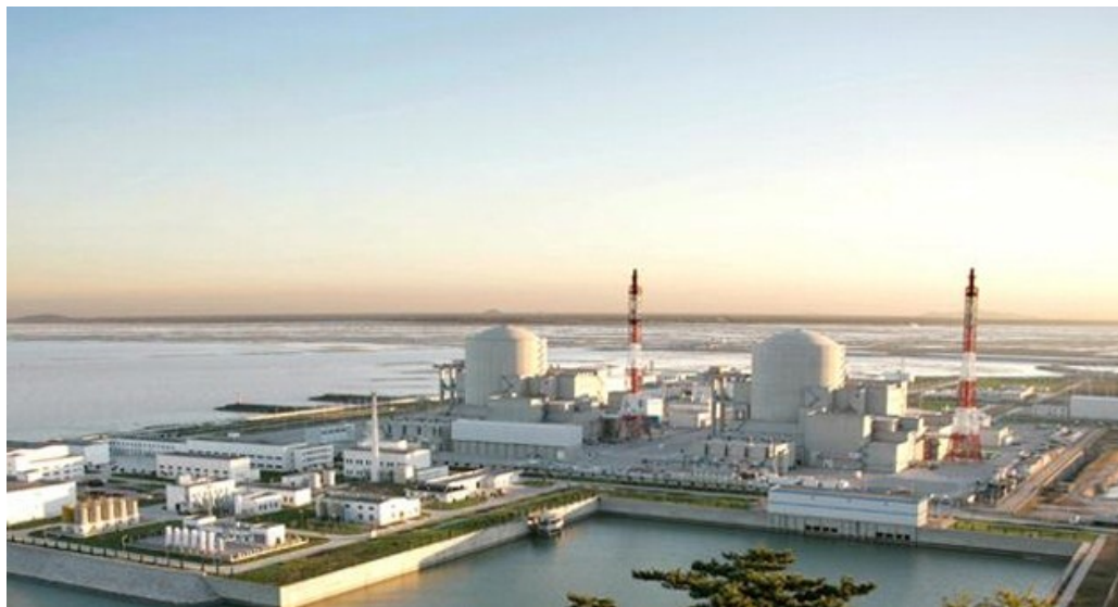
Kuva 2.2.2 Tianwanin ydinvoimala Kiinassa valmistui vuonna 2007. Laitos perustuu suomalaiseen VVER-91-konseptiin, jossa on varauduttu myös reaktorin sulamiseen.
