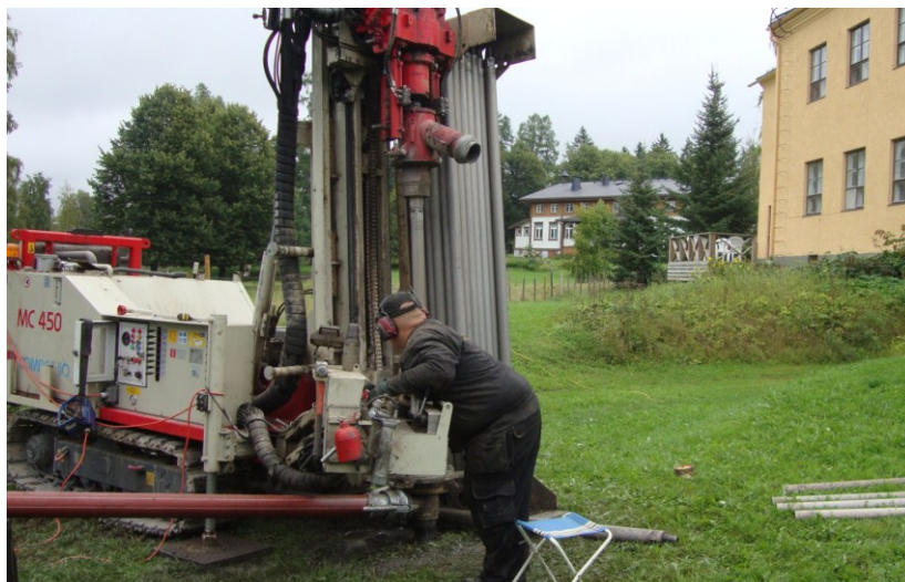
Kuva 5.5.4 Maalämpökaivojen porausta suuressa kohteessa.
