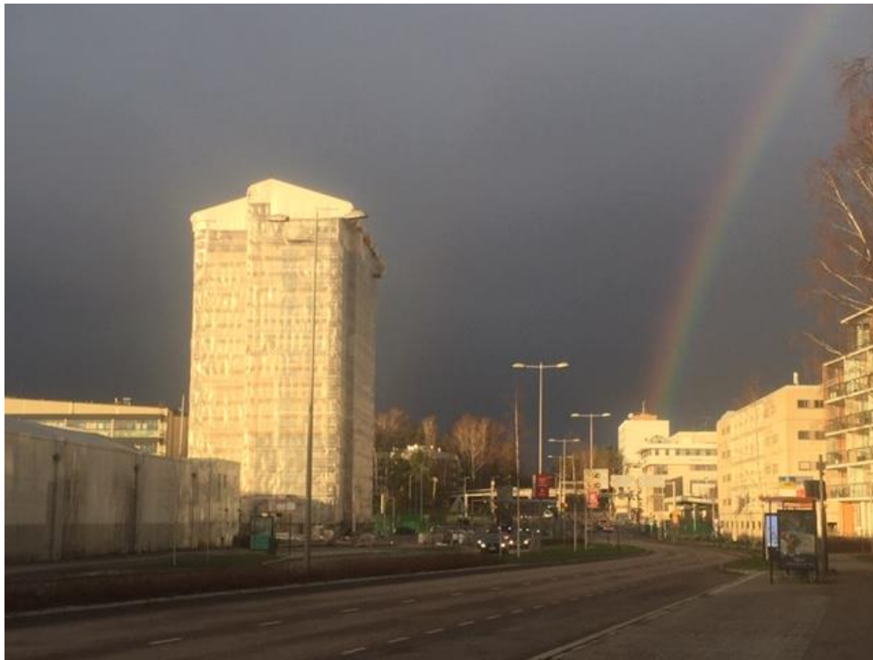
Kuva 14.1.1 Puusta tekeillä oleva 12-kerroksinen HOASin kerrostalo marraskuussa 2020.
